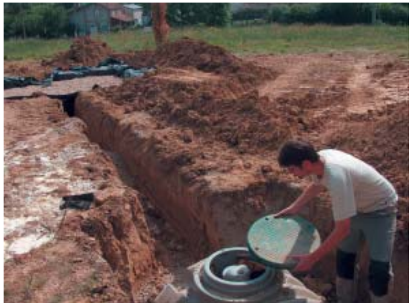
Contrôle d'une installation d'assainissement
